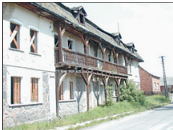
Drewniany balkon domu pracowników folwarcznych w Czachorowie.
